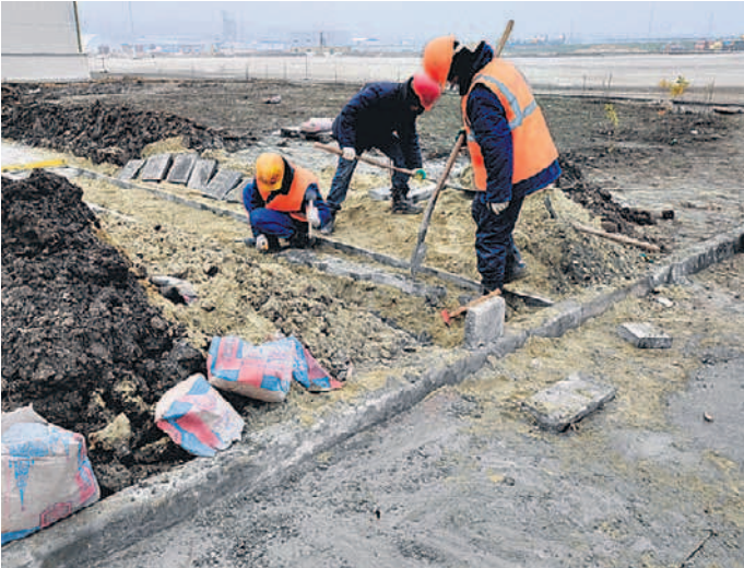
FINPUTSNING. Turkiska byggarbetare stensätter en av ingångarna till fabriken.
